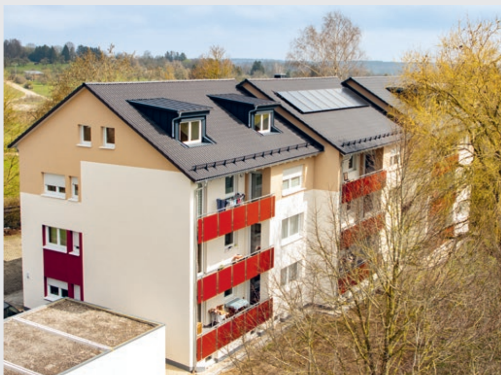
Neue Dachgauben in der Zeppelinstraße 17 und 19 in Gerstetten sorgen seit der Modernisierung für mehr Licht und Wohnqualität.
